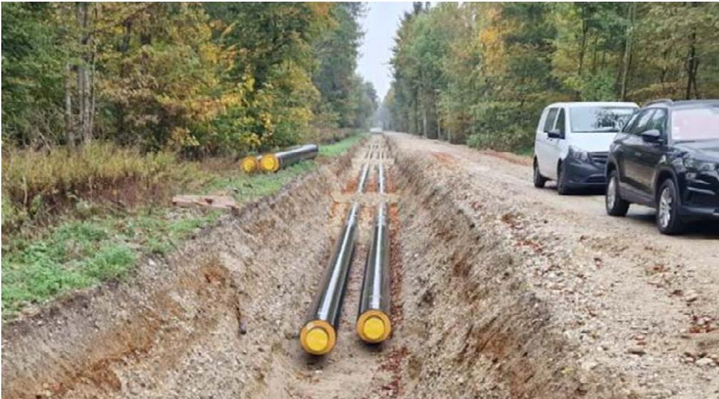
*Abb. 4: Foto von Rohrleitungsverlegung in Forstweg und Baustraße neben Forstweg (Quelle: GEF Ingenieur AG)*
